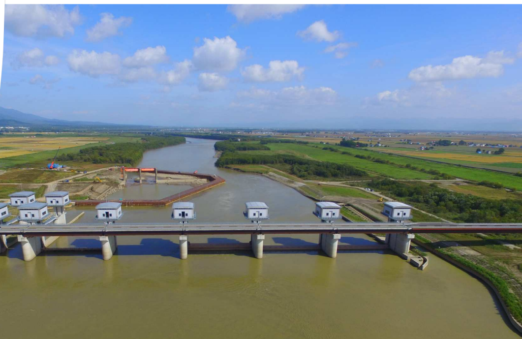
水利施設：頭首工（川の水を水田に引き入れる）
